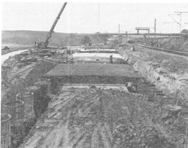
Fig. 7 Los Stammstrecke - Herstellen der Tunneldecke auf dem vorbereiteten Erdplanum und biegesteife Verbindung mit den Großbohrpfählen
