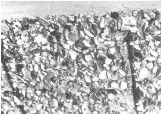
Photographie 3 Détail d'un flan de poteau dont le côté vu a été traité avec un retardateur de surface.
