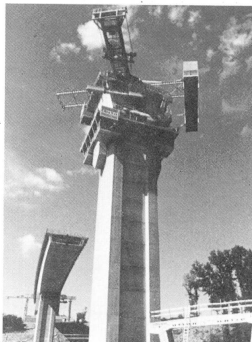
Photo 5 : Pose des voussoirs
