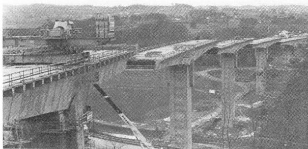
Photo 3 : Vue d'ensemble des fléaux avant basculement
