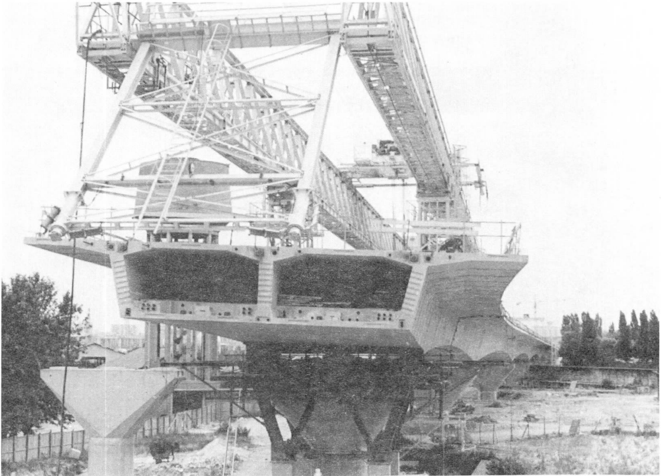
Figure 1 : Vue générale du montage des voussoirs Segmental view of the segment erection
