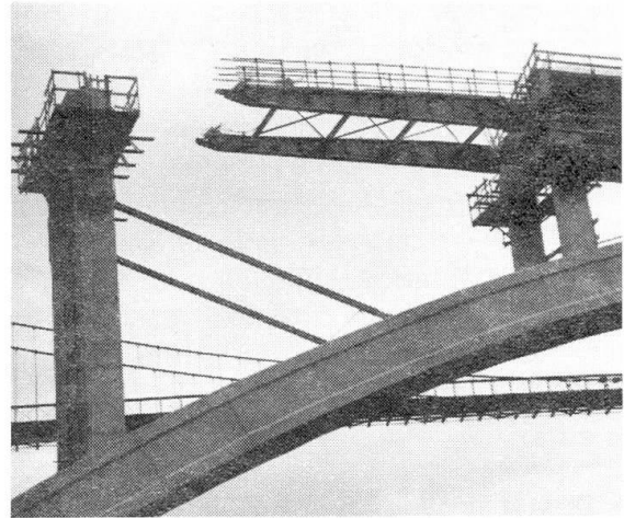
Poussage du tablier sur l'arc
