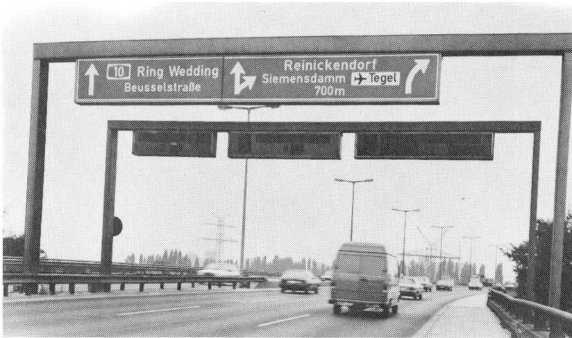
Fig. 1 Schilderbrücken der Berliner Stadtautobahn; vorn Neukonstruktion aus Stahl
