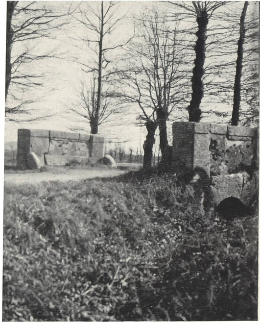
PONT DE MARPIAZ, SUR LA «ROUTE DES PRINCES», A MI-CHEMIN ENTRE PONT BOCHET ET MIOLAN.
