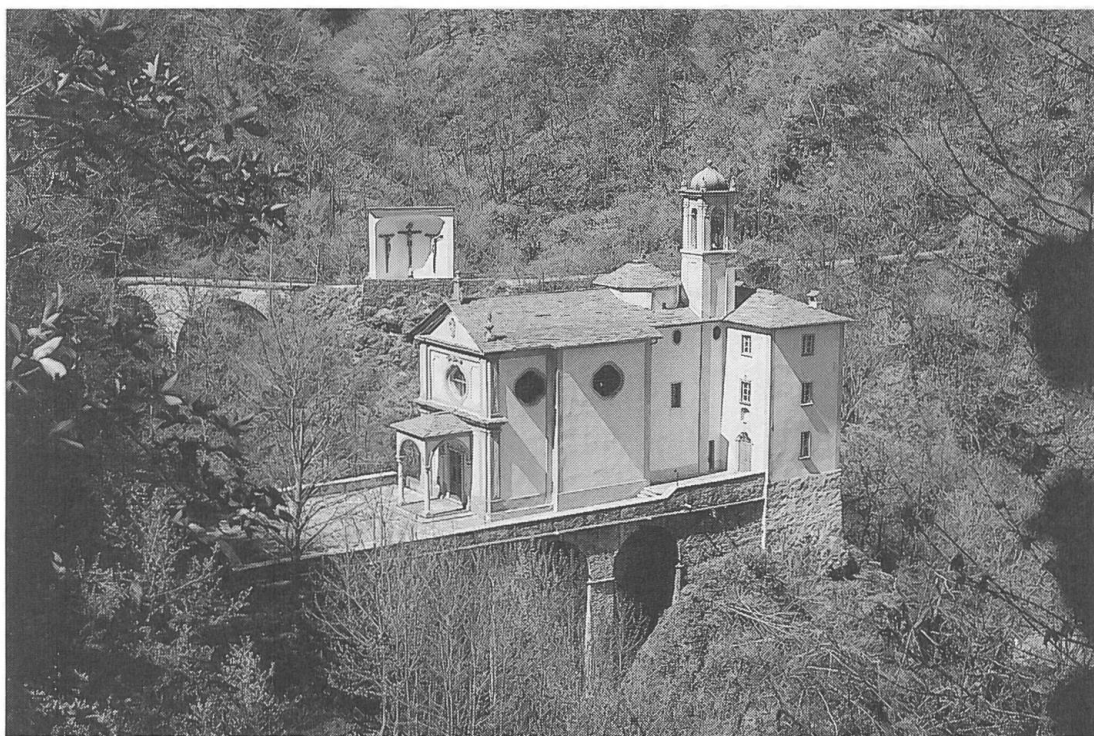
La chiesa dell'Addolorata presso il Sacro Monte di Brissago.
