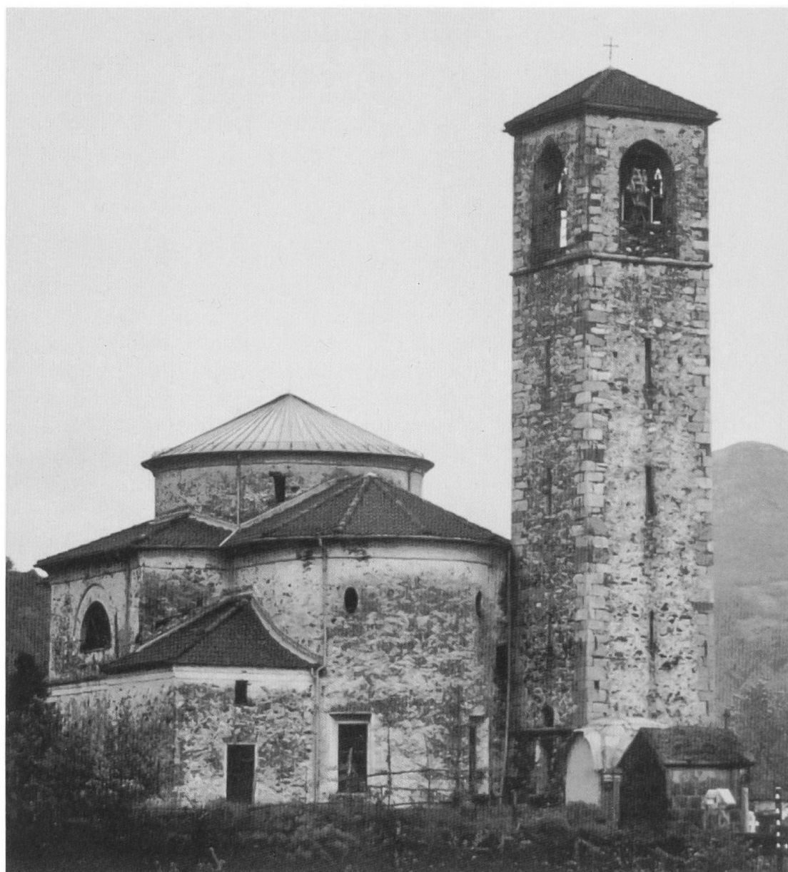
Sant'Abbondio, chiesa dei Santi Abbondio e Andrea.
