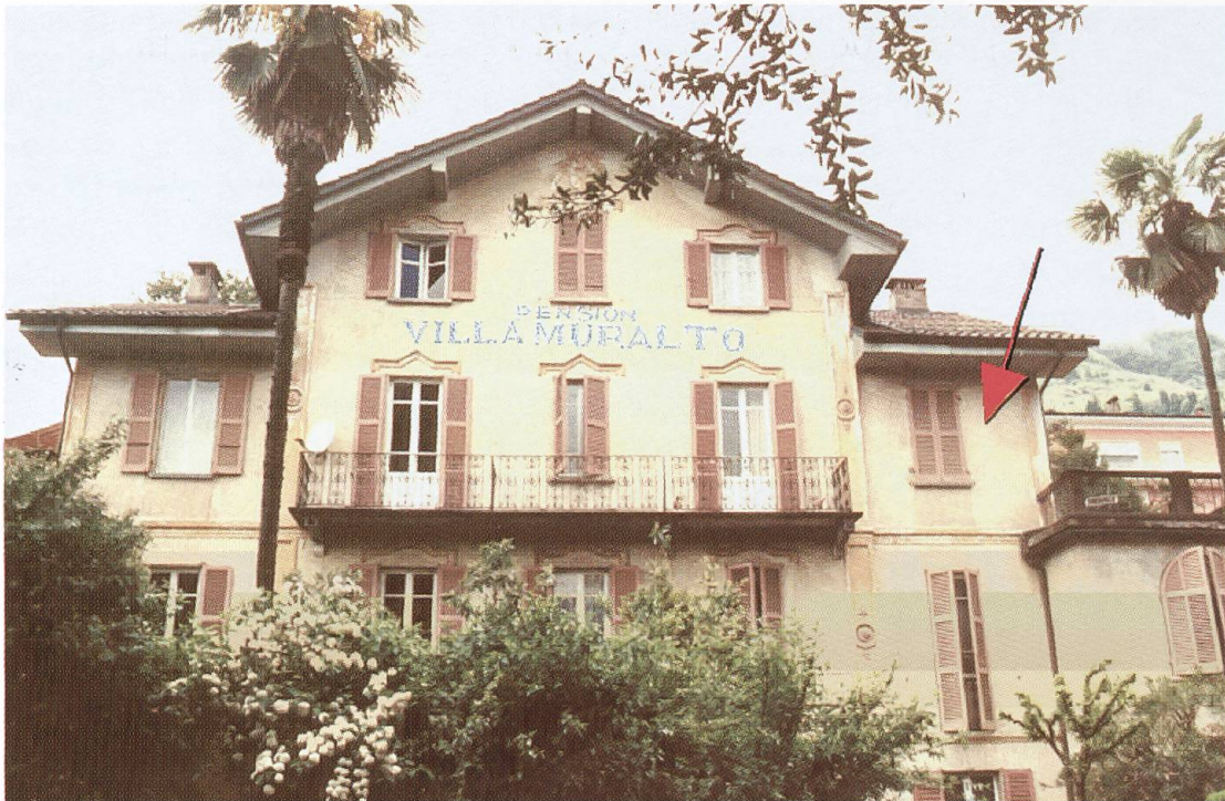
Villa Muralto oggi. La freccia indica l'alloggio di Rilke.
