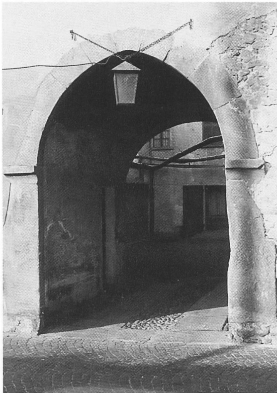
Casa del Negromante. Portale d'ingresso sulla via Borghese.
