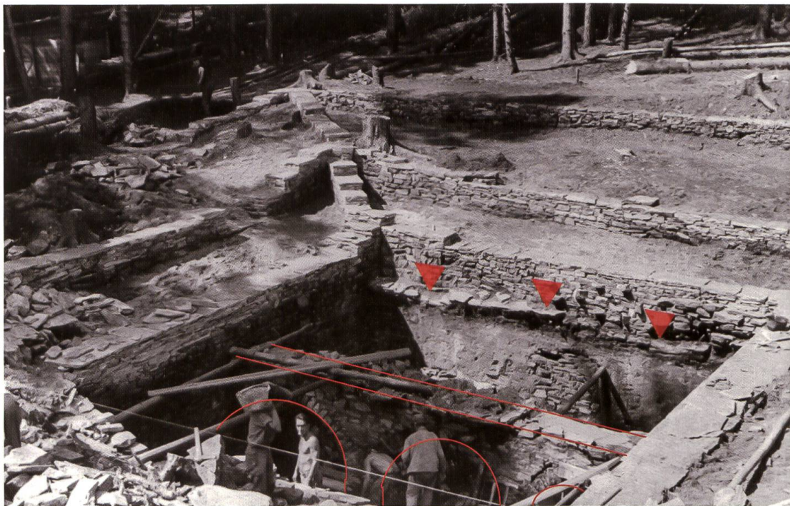
Fig. 6. Vista nord-ovest dell'edificio B1 in corso di restauro. In rosso è evidenziata la struttura ad arco, in secondo piano è visibile la base della volta a botte (frecce). ArCJ, Fonds Alban Gerster, Tegna, modificata dall'autore.
