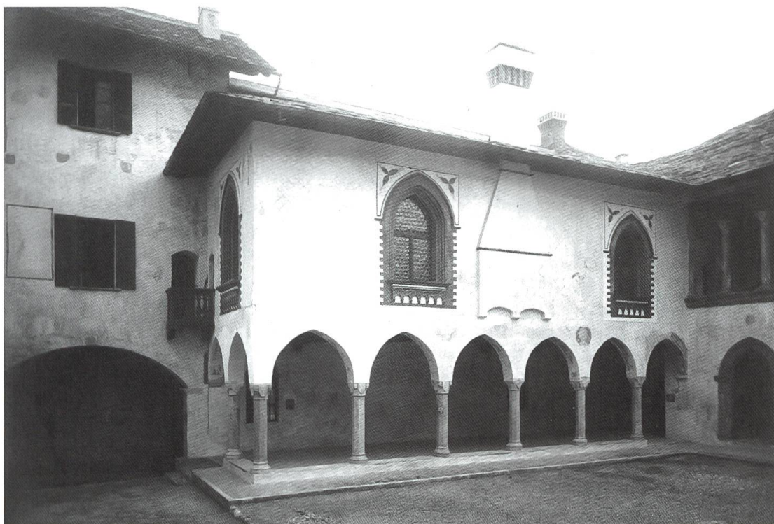
Cortile interno dopo il restauro. Archivio della città di Locarno, Restauro del castello 1922-1926, fotografie.
