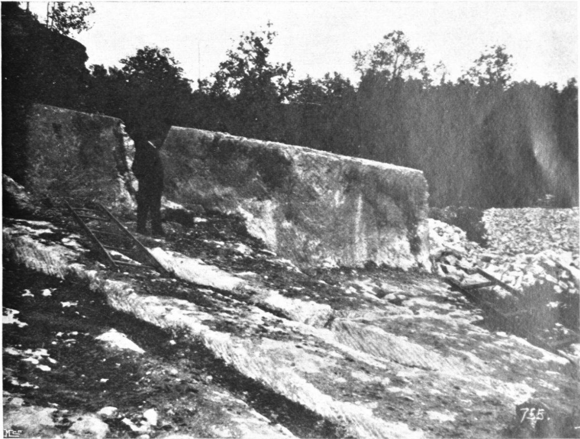
Carrière romaine de la Lance. Vue des tranchées et d'un massif dégagé.
