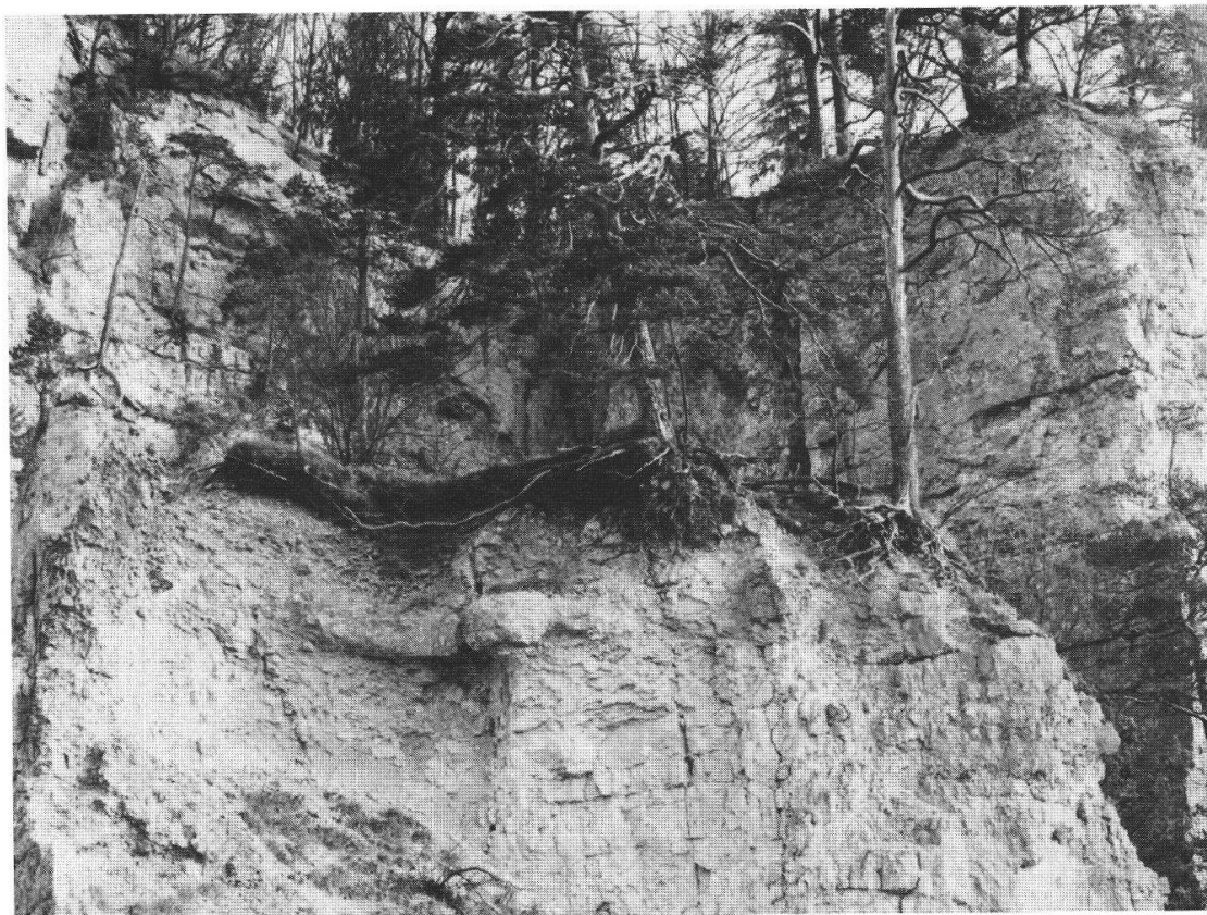
Fig. 3. Vue partielle de l'un des «châteaux». On distingue la paroi principale à l'arrière-plan. La vitesse du recul de la paroi s'observe par la fraîcheur des formes et aussi par les racines des arbres qui pendent dans le vide.
