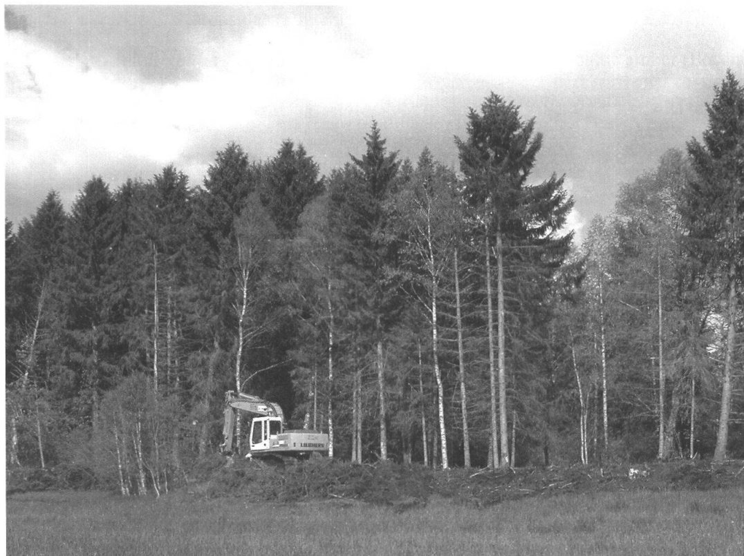
Figure 3: Construction d'une digue sur la lisière sud du Bois-des-Lattes.
