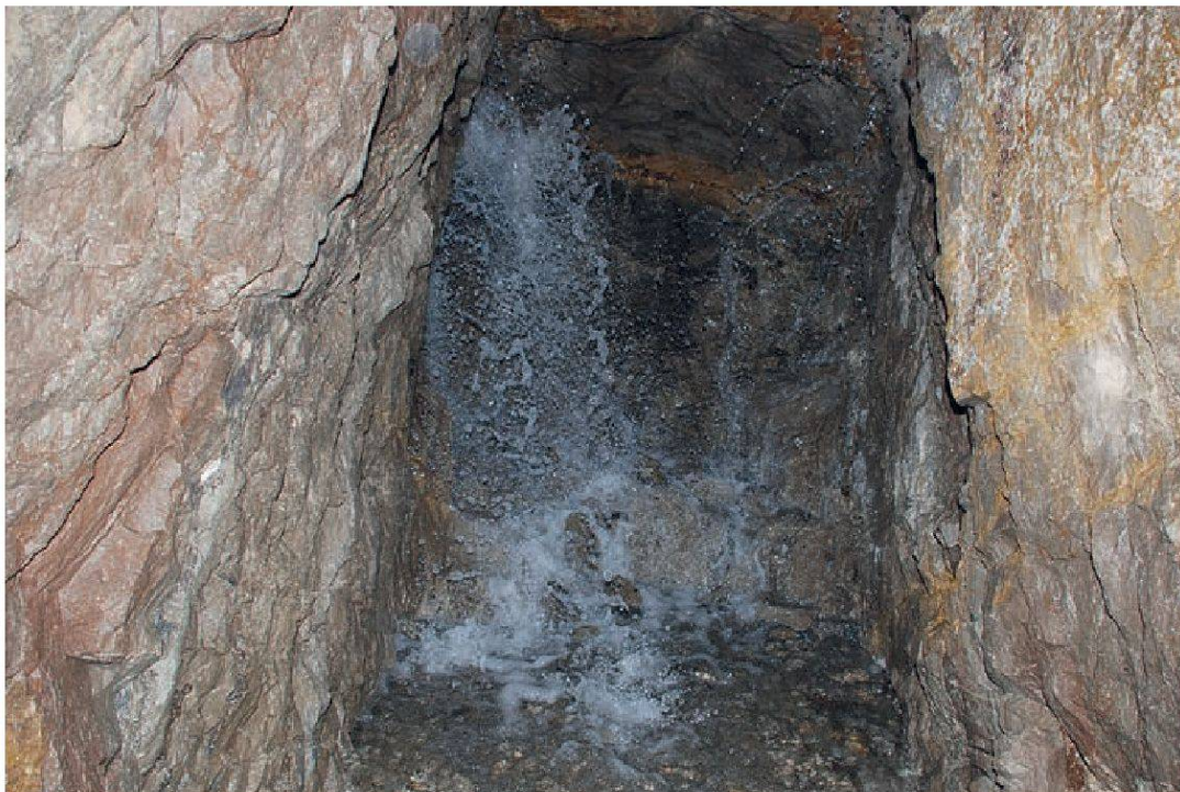
Jaillissement d'eau karstique au fond du captage de la source de la Dalle nacrée aux Moyats
