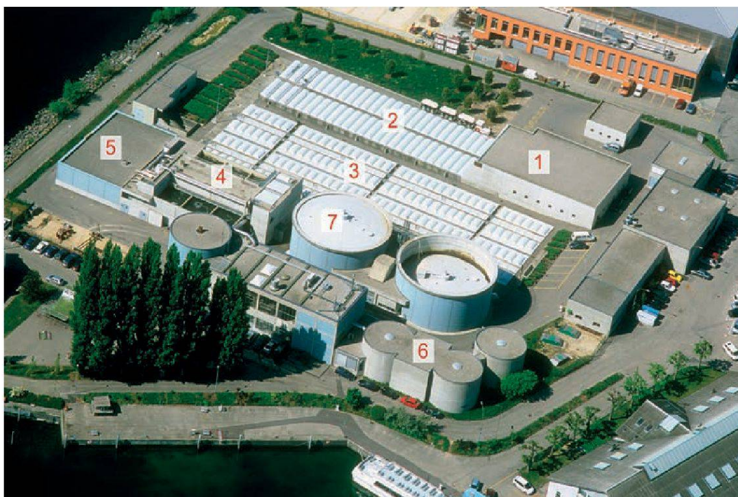
La STEP de Neuchâtel au Nid-du-Crô. En haut à droite, le bâtiment de l'épuration physique (1), suivi des décanteurs primaires (2) ; au milieu et sur la gauche vers le lac, les phases biologiques avec boues activées (3) et biofiltres (4) ; le dernier stade d'épuration par filtres spéciaux se trouve dans le bâtiment bleu (5) au bord du lac, avant le rejet de l'eau épurée. Le traitement des boues par épaissement (6) et digestion (7) s'effectue dans les tours circulaires.
