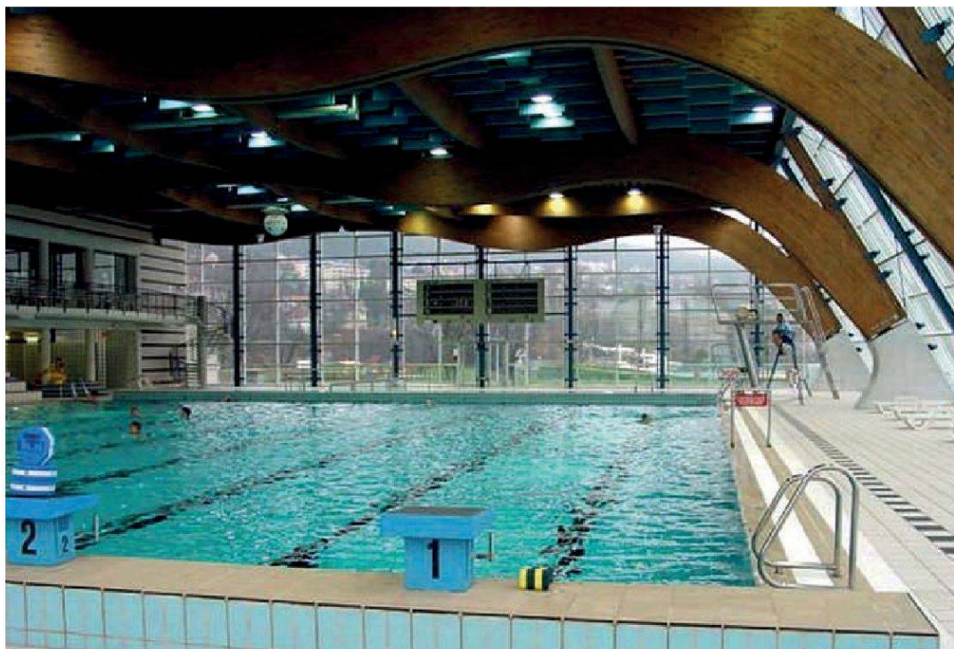
Intérieur de la piscine couverte du Nid-du-Crô à Neuchâtel
