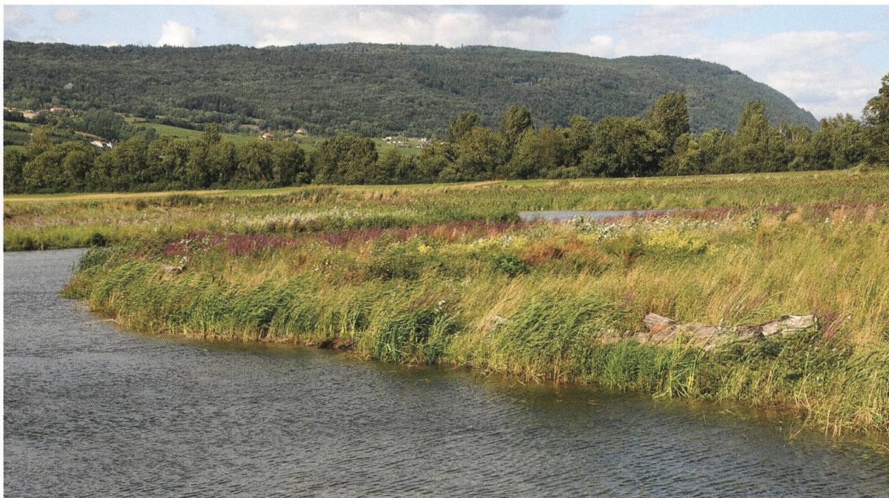
Figure 13. Développement important de la végétation. Photo : L. Juillerat, 12.07.2017.
