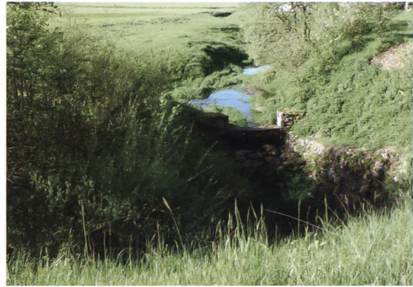
Fossé, retenue et perte, d'arrière en avant
