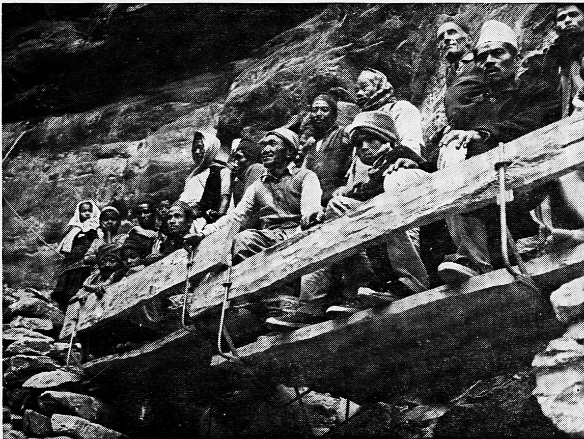
Brückenbau in Nepal. Der Helvetas-Mitarbeiter Alois Lütolf, Chefmonteur aus Luzern (dritter von rechts), mit seinen Leuten bei der Belastungsprobe eines Steges, der zur Traversierung einer Felswand angelegt wurde. (Siehe Bericht Seite 516.)
