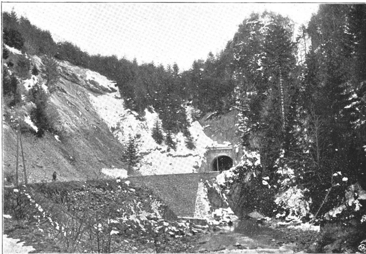
Fig. 1. — Vallée de la Dranse du Biot (Chablais) en aval de St-Jean d'Aulph. (Vue prise de l'aval vers l'amont.) A droite gorge actuelle; à gauche thalweg occupé par l'alluvion glaciaire.
