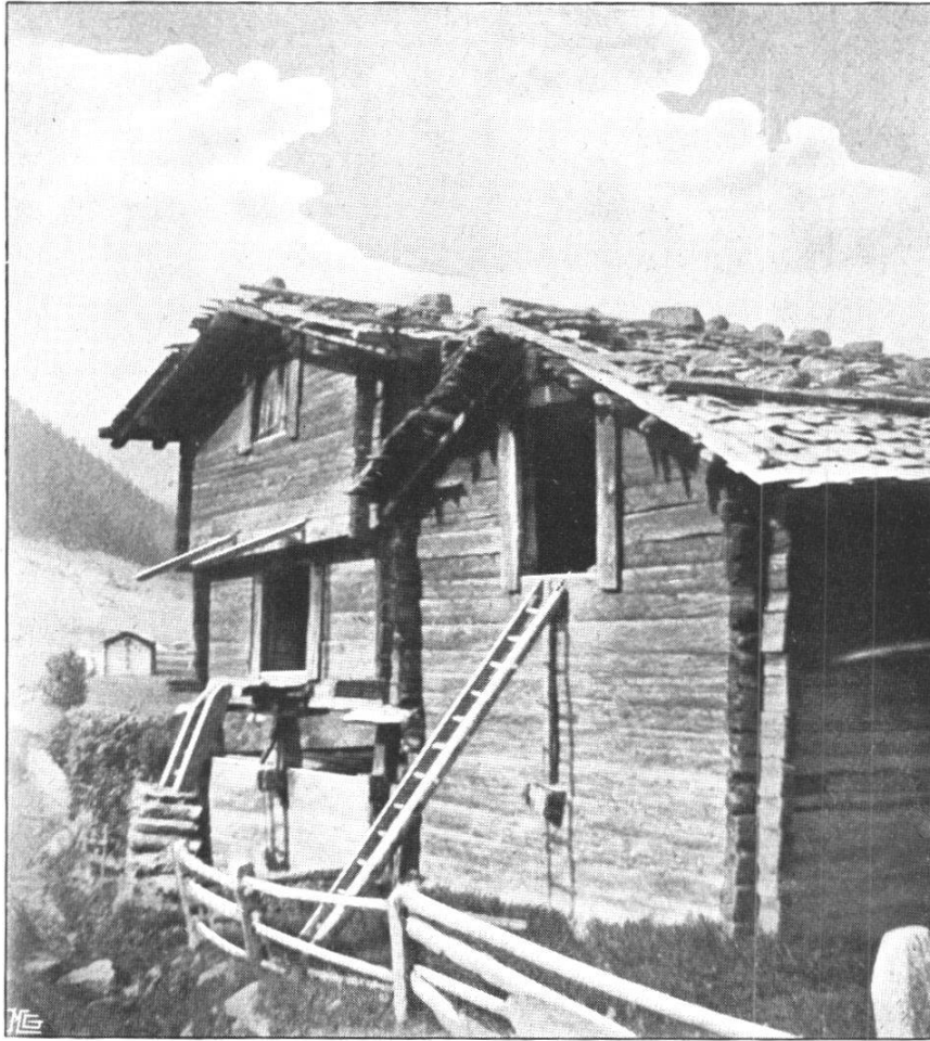
Grange et fenil à Muhlibach.
