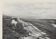
Photo. M. Lagues, 1922. Fig. 8. Matité Sud de la route crevasse et canal dérivé.
