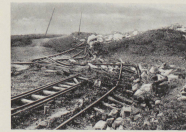
Photo. M. Lagues, 1922. Fig. 11. Zig-zag des voies au Sud de la gouffe.
