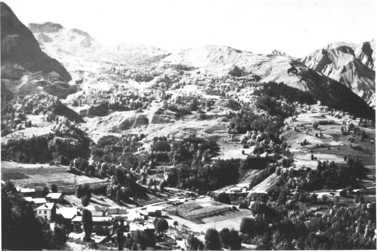
Photo 1. – Aspect caractéristique d'un versant ayant subi un glissement généralisé. Zone houillère briançonnaise, rive gauche du Doron de Belleville à Saint-Martin de Belleville (Savoie). Cliché P. ANTOINE.
