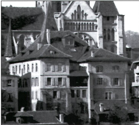
Figure 6. La maison Morave ou maison Gaudard achetée par l'État en 1873 (voir annexe 2). Les bureaux de l'Instruction publique occupent l'étage du haut à gauche, le musée de géologie l'étage du haut à droite, et les deux musées, géologie et botanique, occupent l'étage juste au-dessous, avec un auditoire commun pour l'enseignement (extrait d'une carte postale prise en direction de la cathédrale vers 1900).
