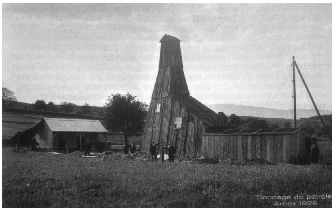
Figure 12. Vue des installations de surface à Arnex en 1929 qui ont un petit air de Pennsylvanie du XIX e siècle.
