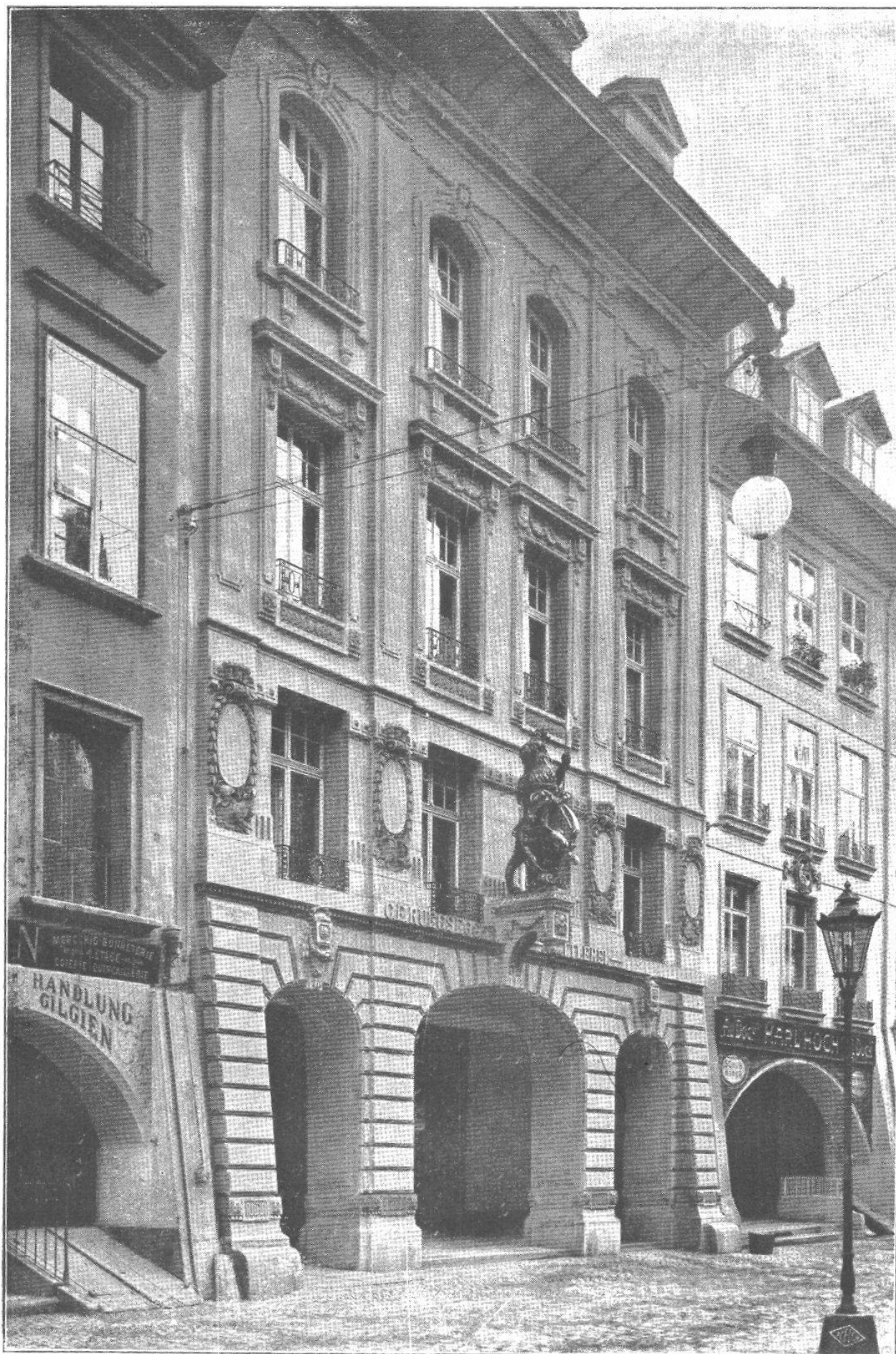
Die neue Hauswand gegen die Marktgasse, erbaut 1905–06 von den Architekten Lindt & Hofmann.
