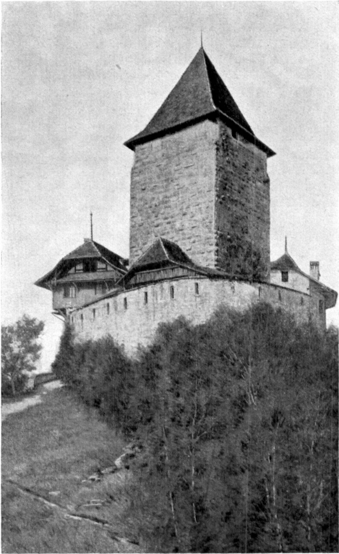
Schloß Trachselwald. Ansicht von Osten, von Maler A. Blau, nach dem Luminoverfahren. (Mit dem Zufahrtwege.) (Original im kant. Rathaus in Bern.)
