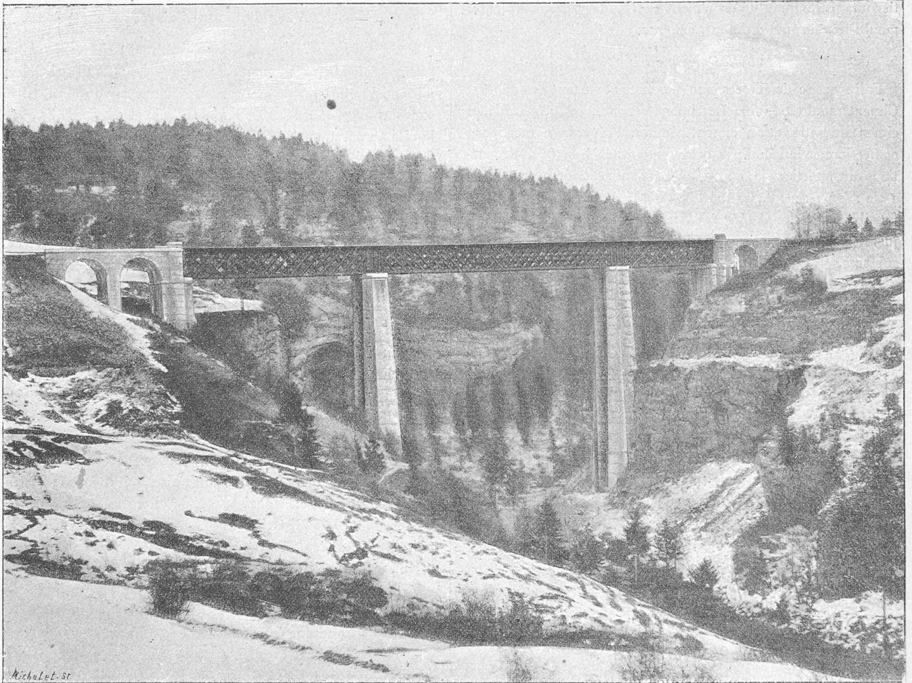
Fig. 1. — Viaduc de Vallorbes.
