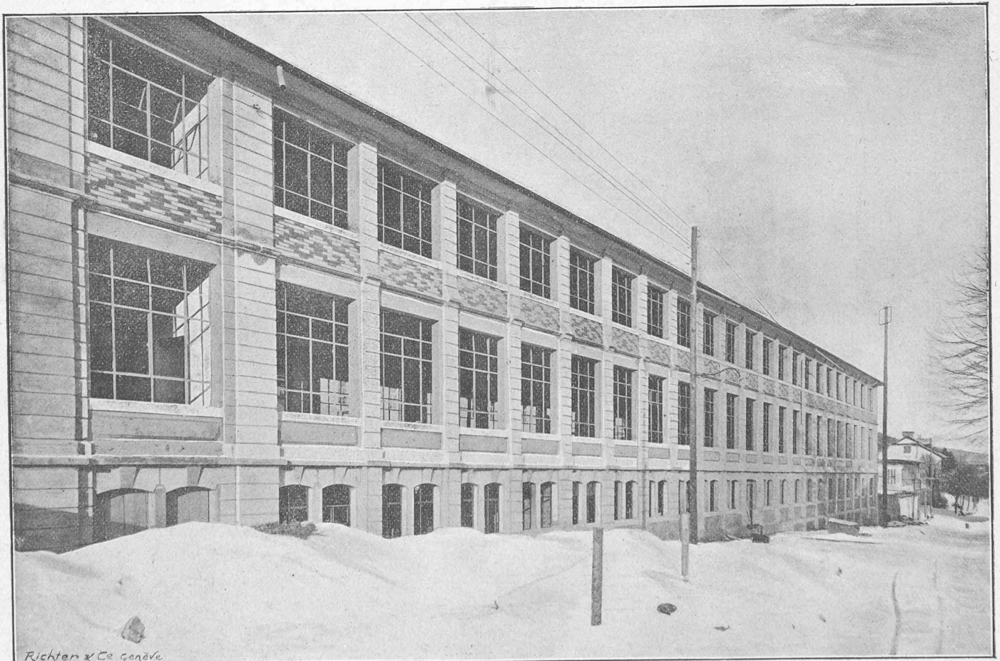
Nouvelle usine de MM. Robert, à Fontainemelon (canton de Neuchâtel). — Façade principale.
