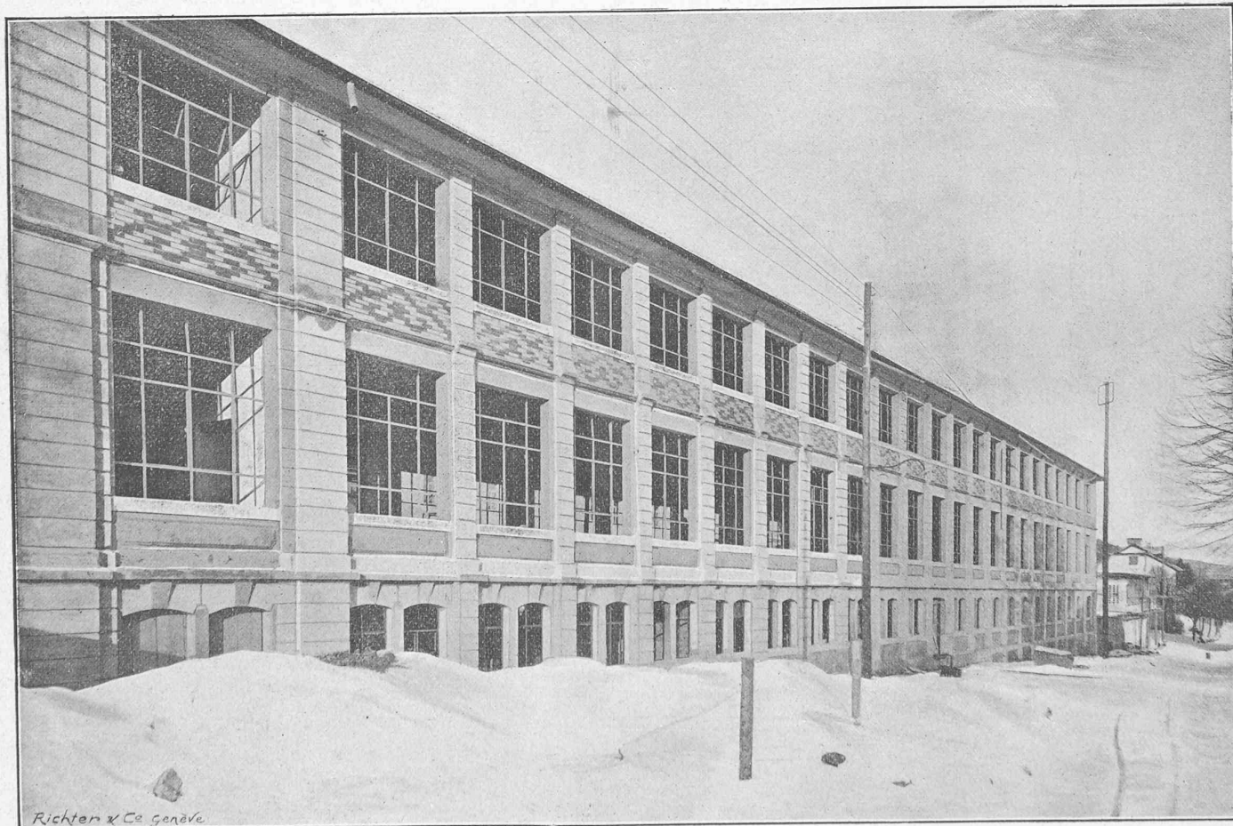
Nouvelle usine de MM. Robert, à Fontainemelon (canton de Neuchâtel). — Façade principale.
