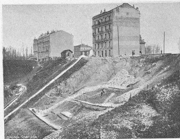
Fig. 1. — Vue prise après l'éboulement du remblai des Pilettes.
