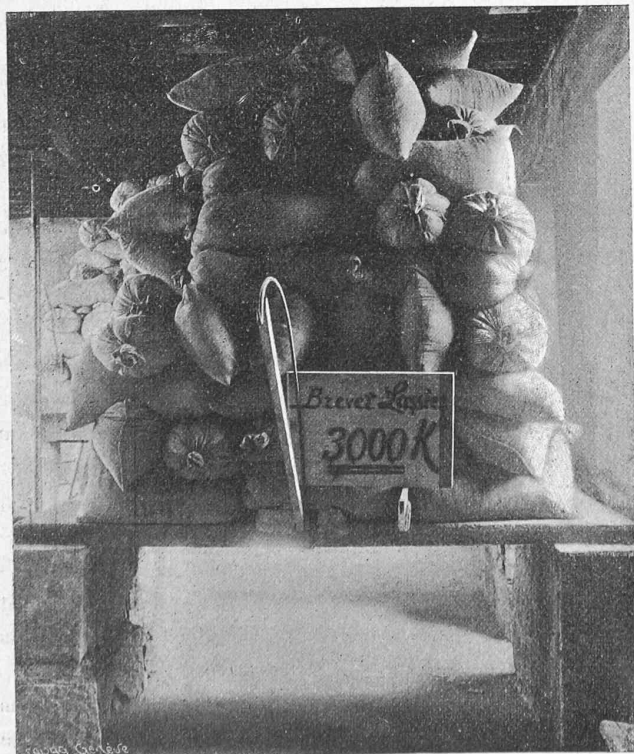
Fig. 5. — Essai de charge d'une dalle en béton armé système Lossier.
