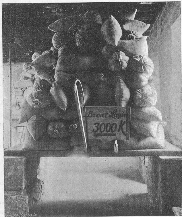
Fig. 5. — Essai de charge d'une dalle en béton armé système Lossier.
