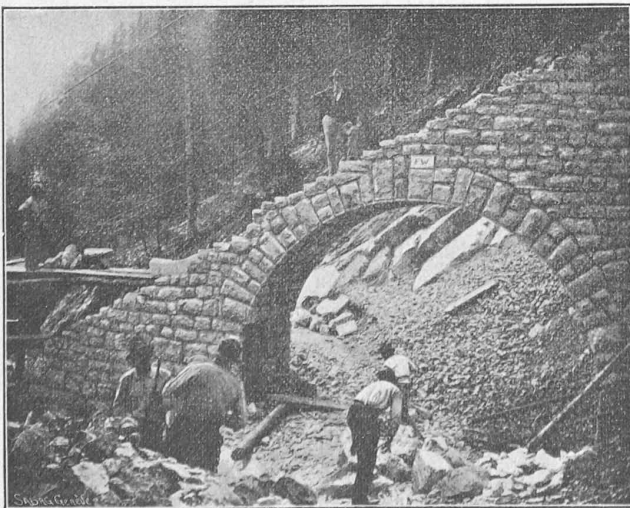
Fig. 10. — Voûte sur la « Charrière ».
