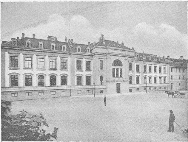
Fig. 7. — Bâtiment de physique et chimie.
