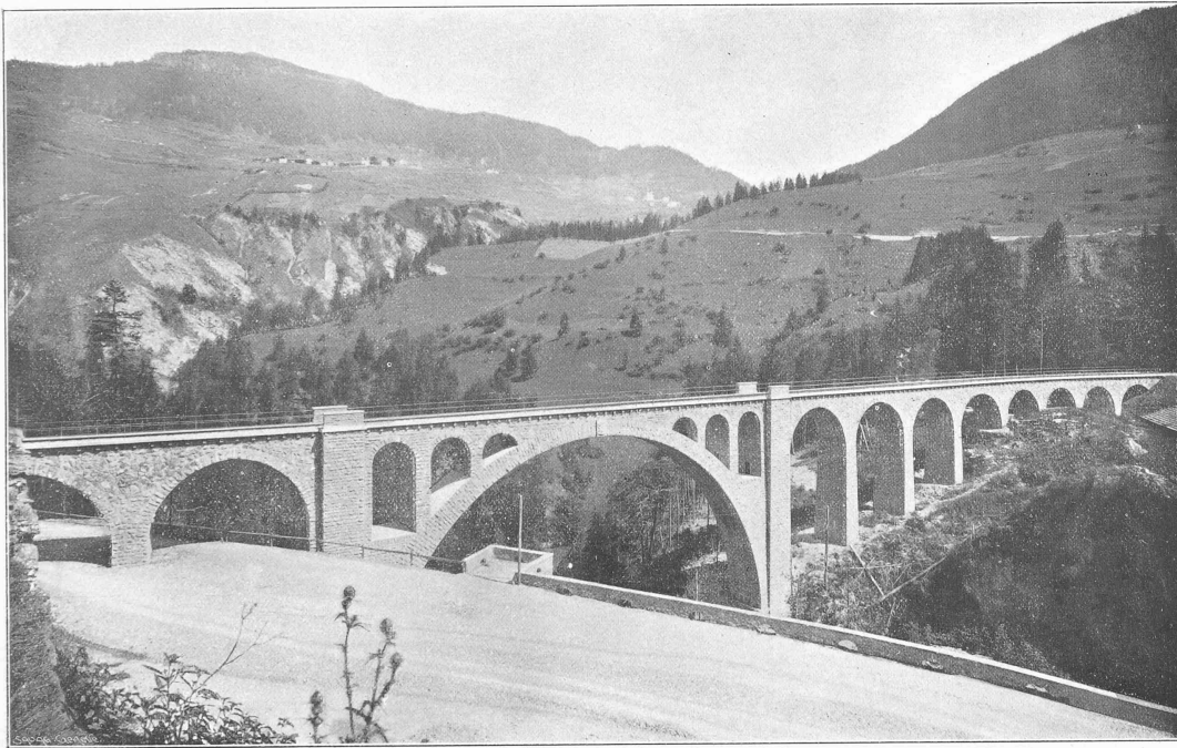
LES NOUVELLES LIGNES DU CHEMIN DE FER RHÉTIQUE. — VIADUC DE SOLIS. 10 arches de 8 et 10 m. et 1 arche centrale de 42 m. d'ouverture. Hauteur 90 m.
