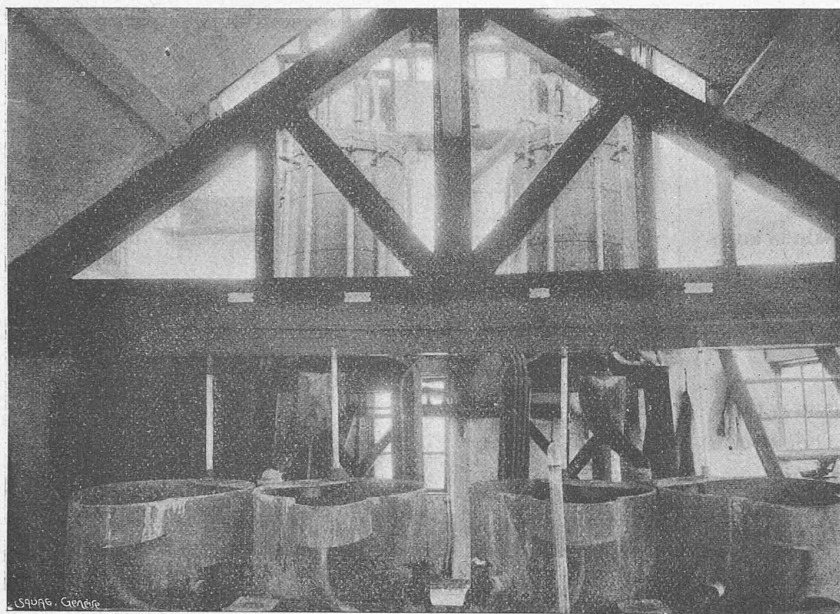
Fig. 6. — Appareils pour la fabrication de la nitroglycérine. — Vue générale.
