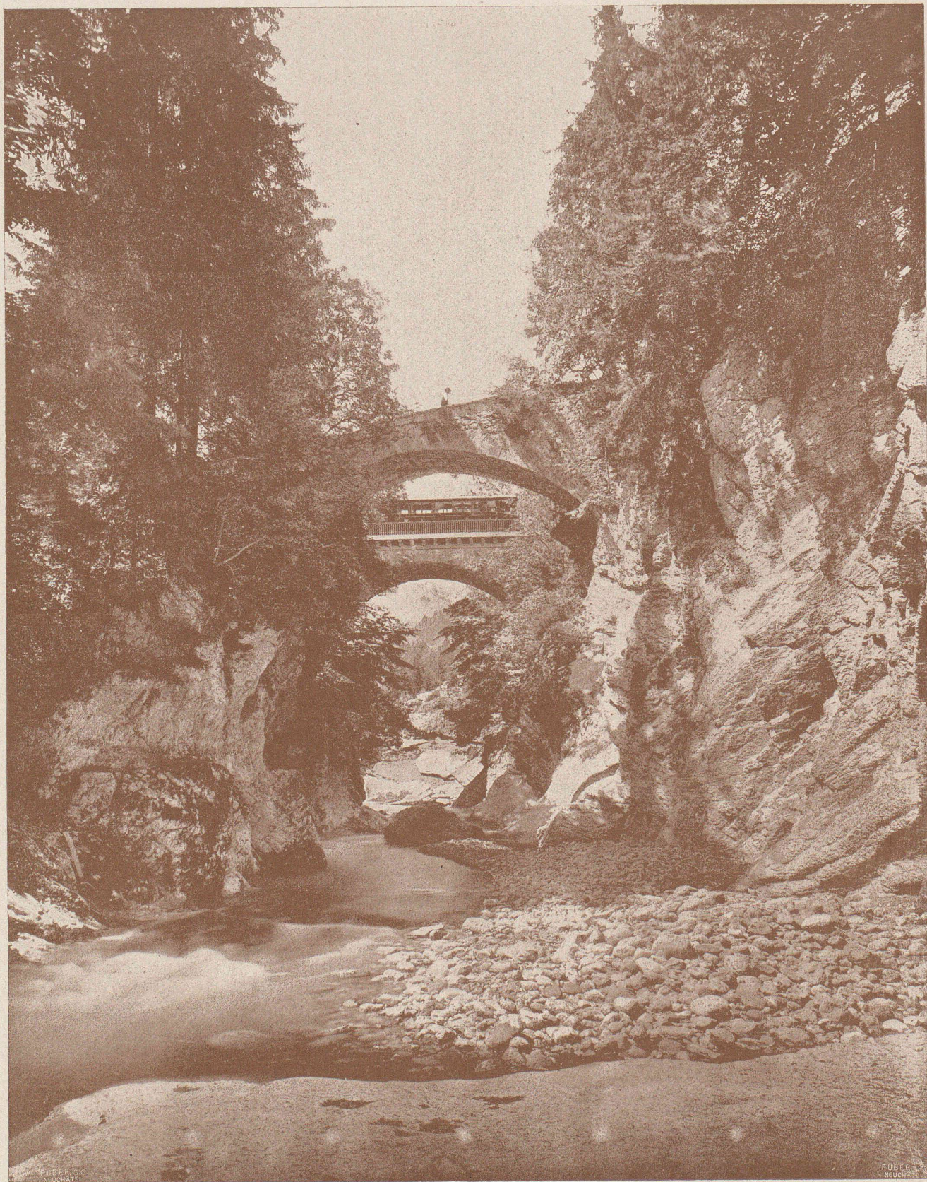
CHEMINS DE FER ÉLECTRIQUES DE LA GRUYÈRE. — PONT SUR L'HONGRIN.
