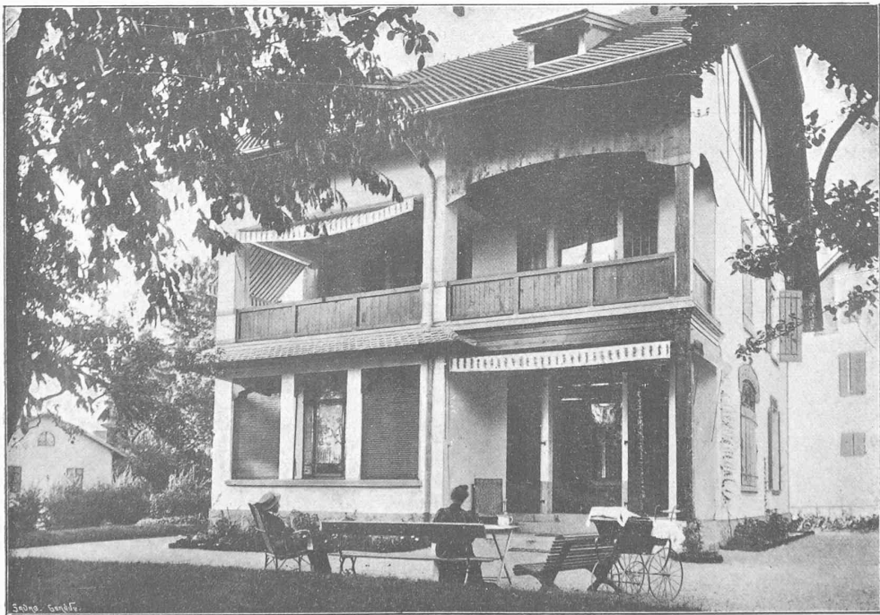
Façade au Sud.
