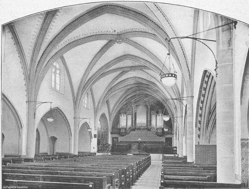
Fig. 16 bis. — Intérieur du temple de St-Gervais, après la restauration.
