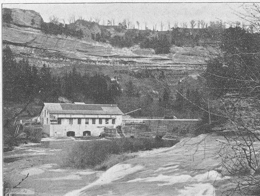
Fig. 6. — Usine de la Maigrage sur la Sarine.
