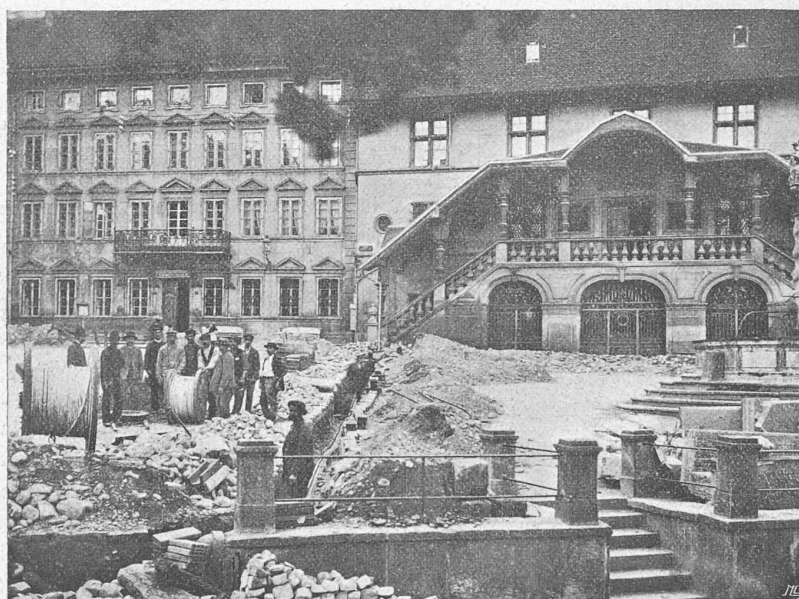
Fig. 10. — Pose des câbles devant l'Hôtel cantonal.
