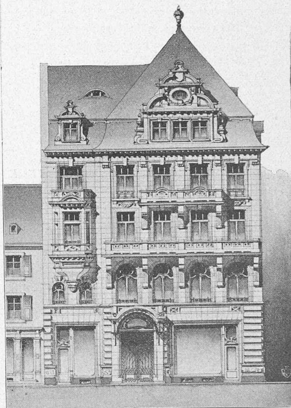
Façade sur la rue Léopold Robert.
