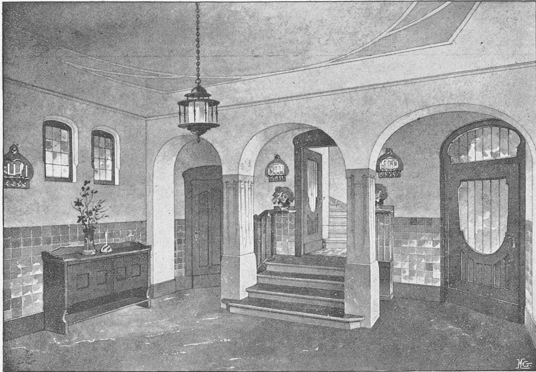
Fig. 54. — Vestibule de la villa « Fieser », à Baden-Baden. — Architecte : M. Riemenschid, à Munich.
