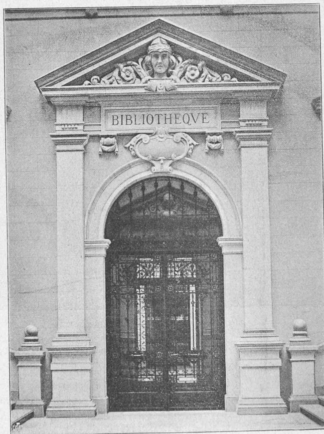
Fig. 19. — Portes latérales de l'Atrium (corps central).
