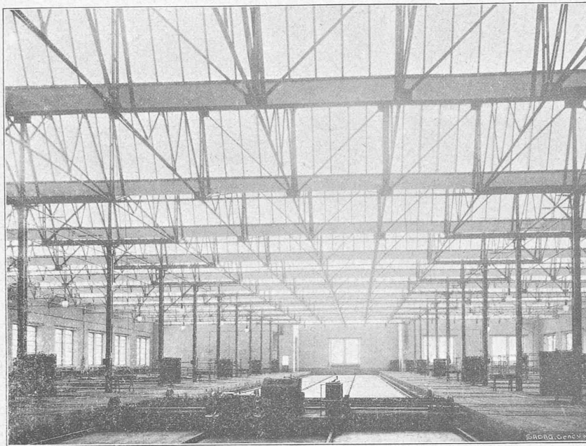
Fig. 12. — Halle de montage des locomotives avec chariot transbordeur.
