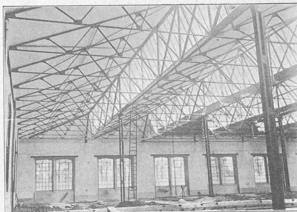
Fig. 13. — Vue intérieure du montage des locomotives. Constructeurs de la charpente métallique Wartmann & Vallette, Brugg.
