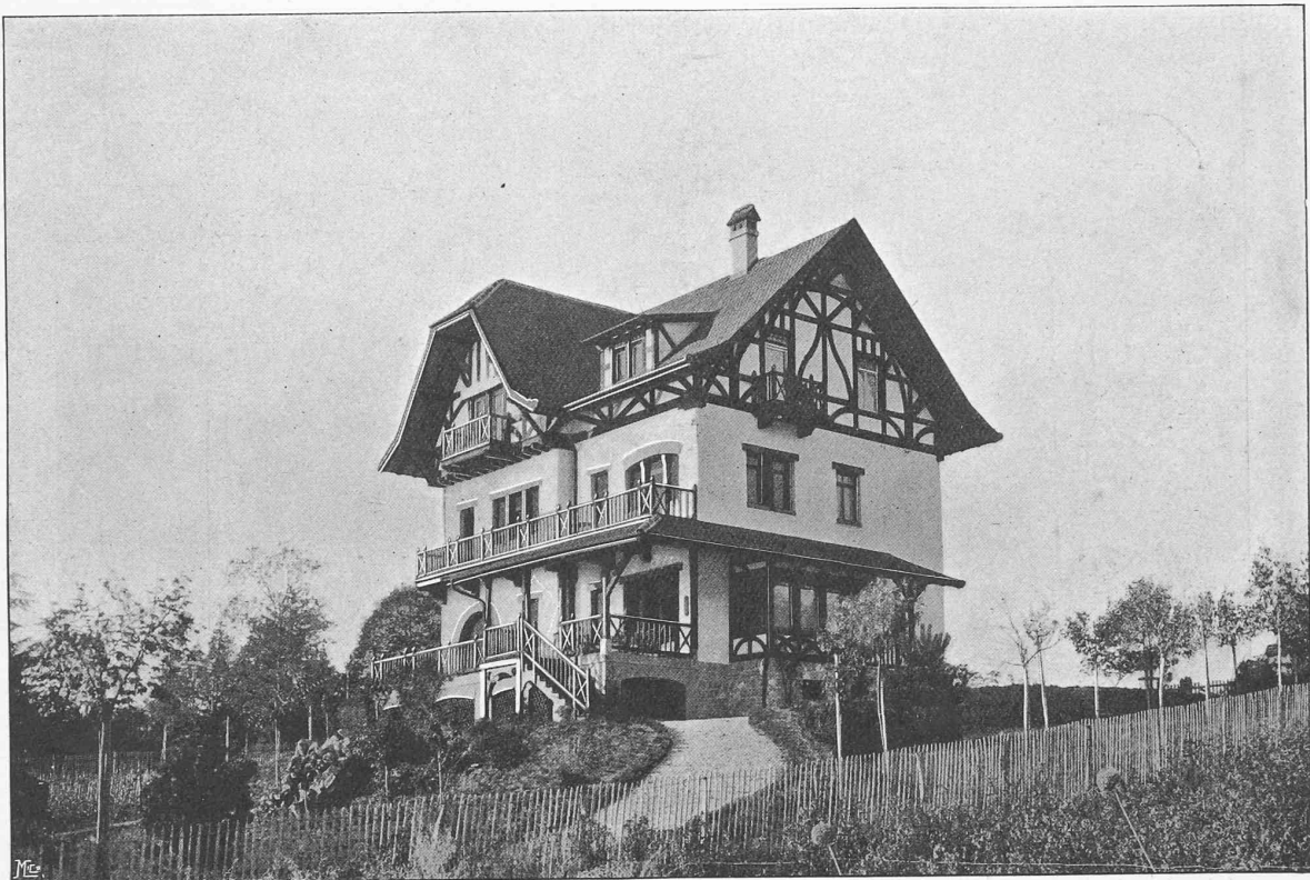
Fig. 2. — Villa Maria-Belgia à La Tour-de-Peilz. — Architectes : MM. Nicati et Burnat, à Vevey.
