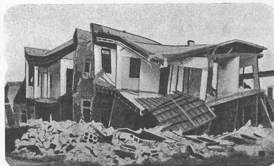
Fig. 1. — Brisure des constructions en bois, ce qui montre l'insuffisance de liaison entre les diverses parties de la construction.
