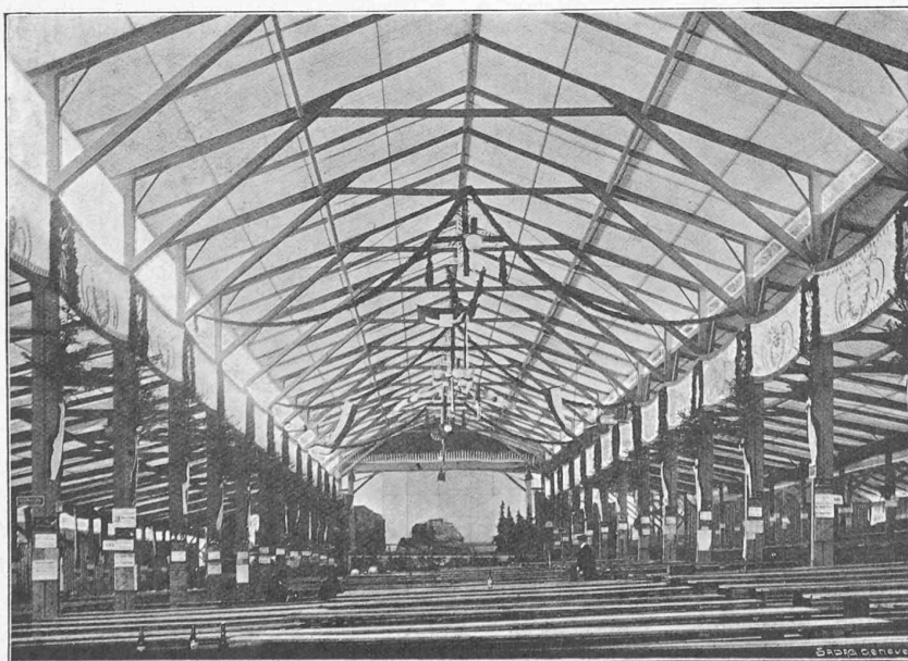
Fig. 2. — Vue intérieure de la cantine.
